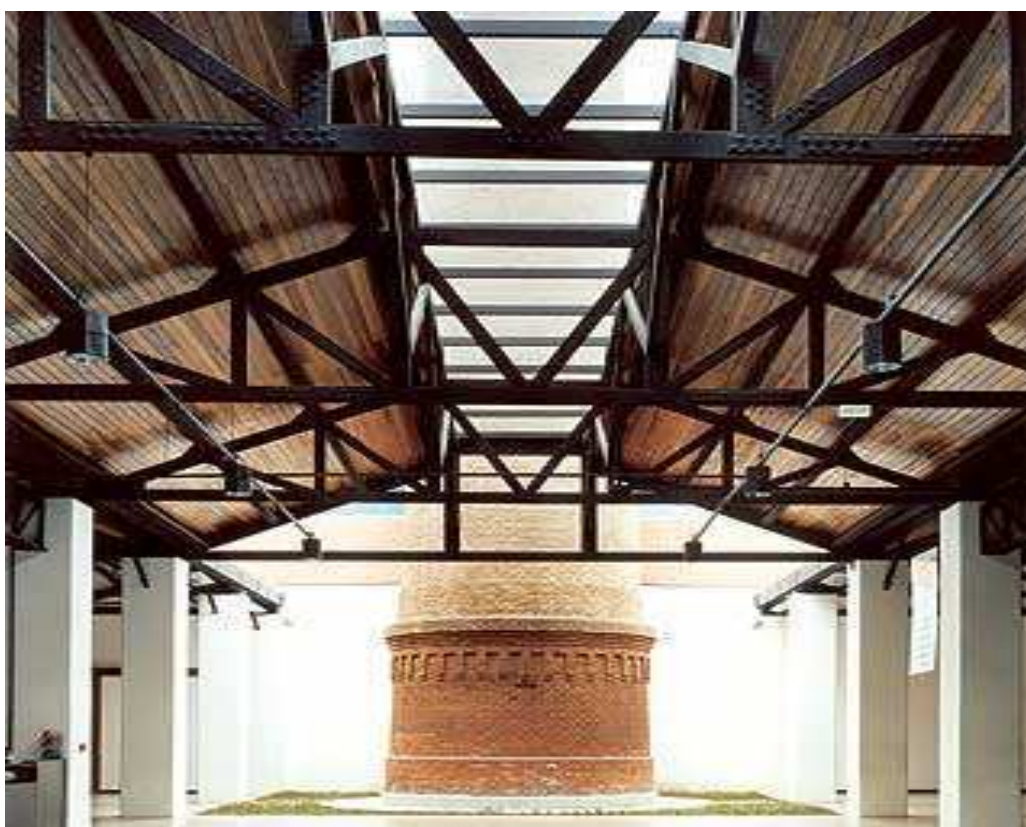
Base da chaminé
