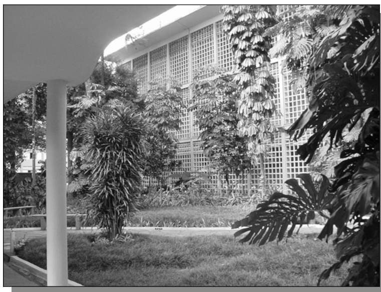
Figura 18 – Prédio da R. Marquês de Paranaguá n. 111 – Acervo ACI.
