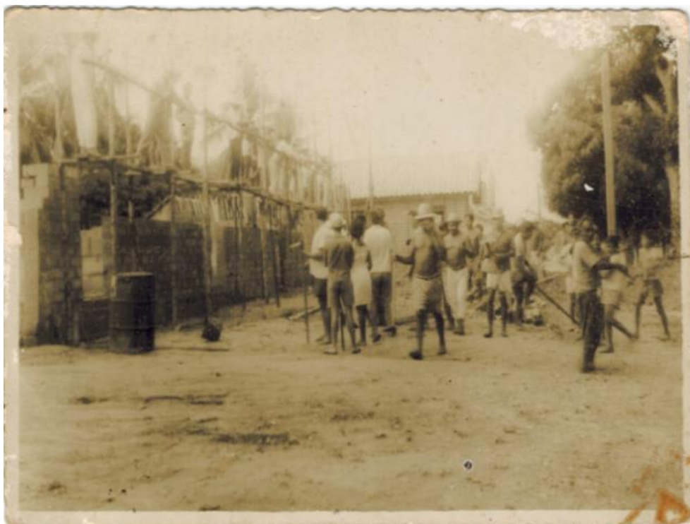
Fotografia 13 – Canteiro de obra e as paredes do grupo escolar levantadas, 1967.
