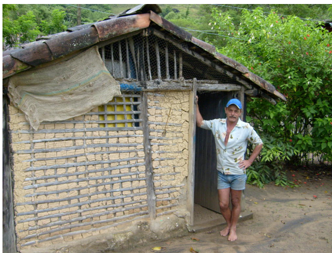
Figura 25: Casa de Pau-a-Pique em janeiro de 2008
