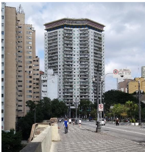
Fig.06 Fotografia do edifício Viadutos e do Viaduto 9 de Julho. Foto: Camila Geracelly
