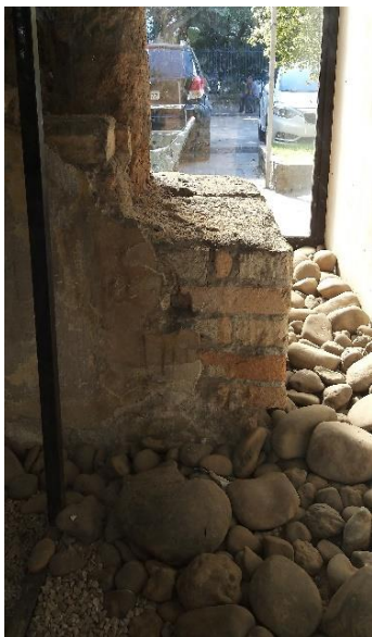
Fig.25 Fotografia da parede de taipa de pilão do Collegio. Foto: Camila Geracelly
