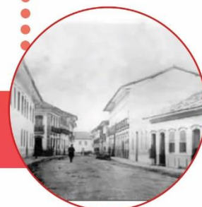
4 - RUA DO CARMO
