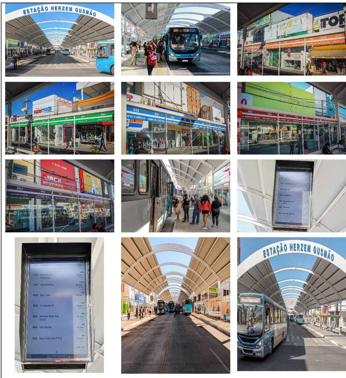
Figura 5 - Estação em funcionamento
