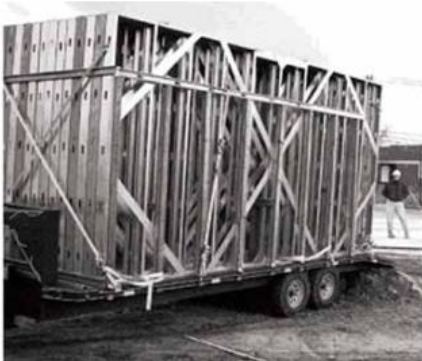
Figura 8: Elementos estruturais pré-fabricados em oficinas e levados para a montagem da estrutura. FONTE: Freitas e Castro, 2006.
