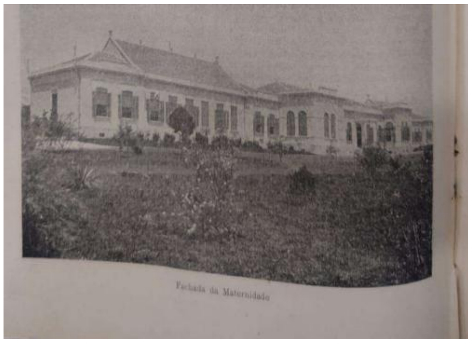
Figura 1 - Fachada da Maternidade
