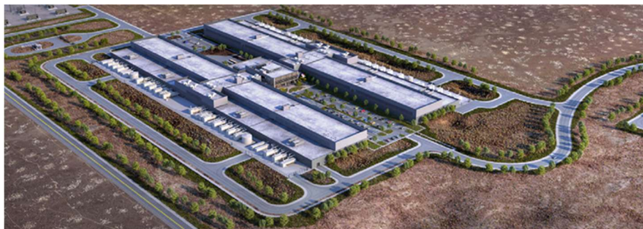
Figura 6: Projeto de Data Center da Meta
