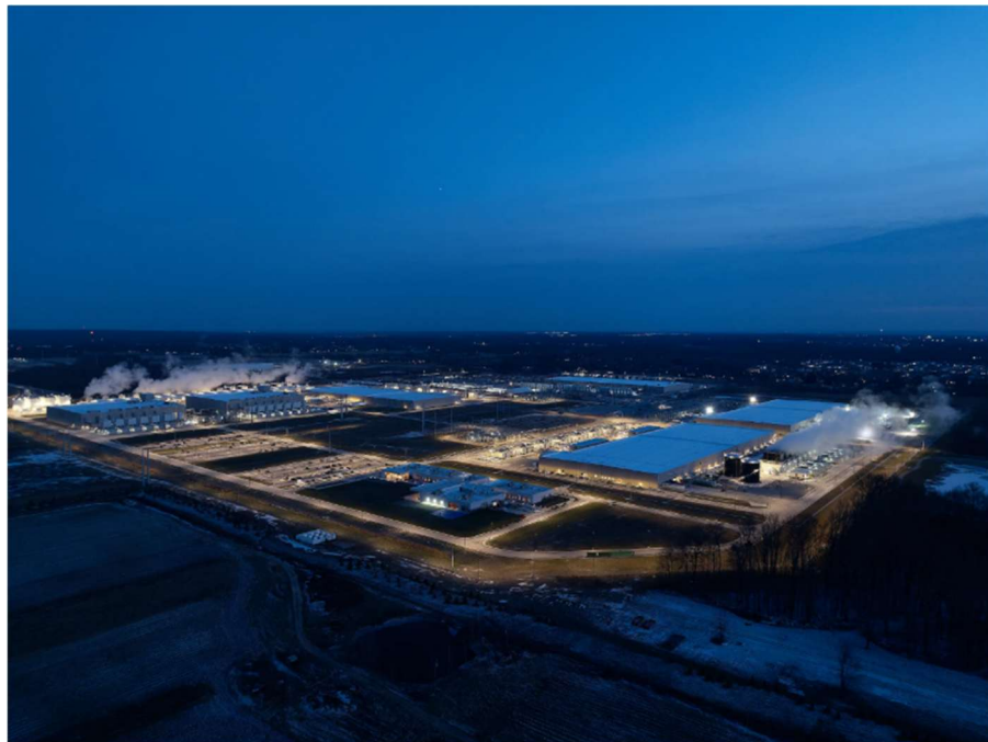
Figura 5 – Data center do Google em Ohio, Estados Unidos
