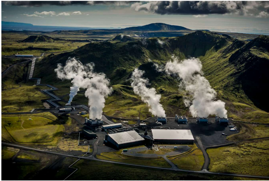
Figura 15: Usina elétrica Orca na Islândia
